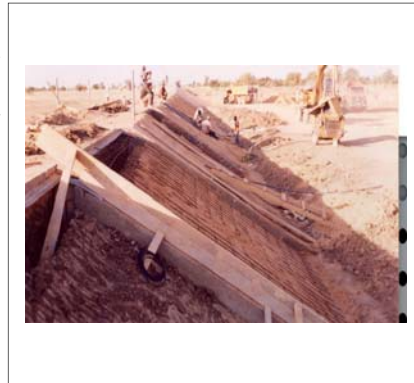
Une vue de la digue en construction du barrage de Boulignoudi
