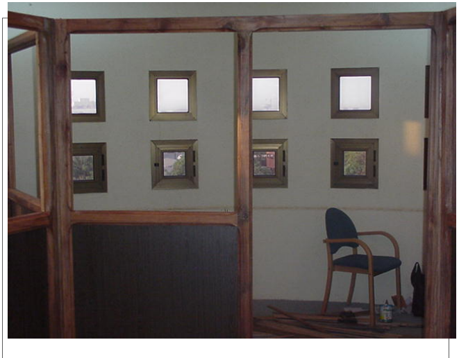
Le service center du PNUD en réfection
