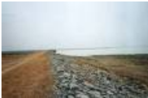
Le barrage de Belga
